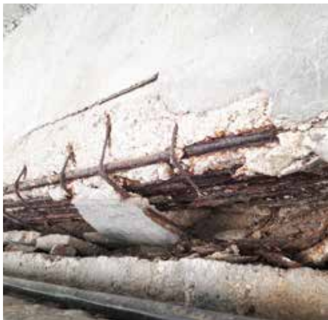
Кородирана арматура како последица на карбонизацијата на бетонот
