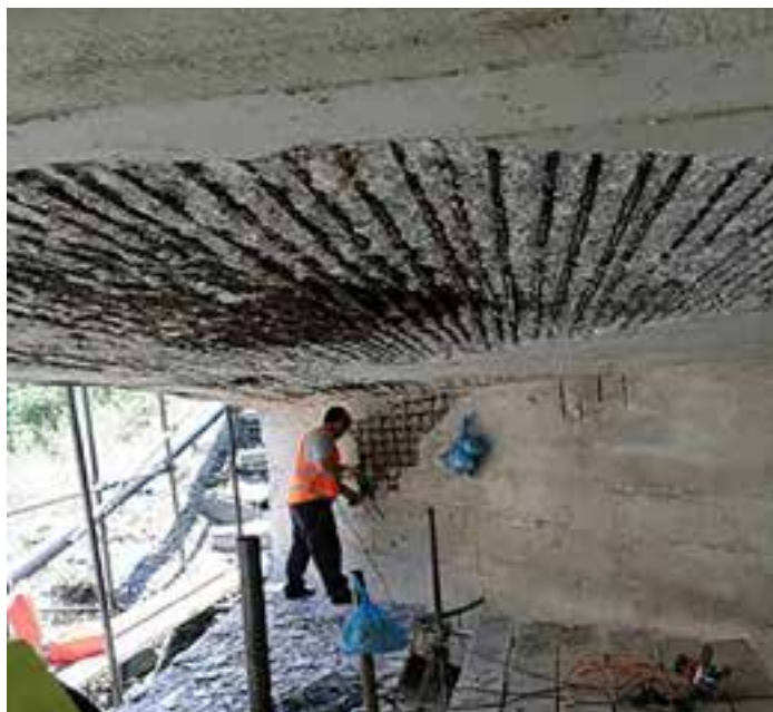
Кородирана арматура како последица на карбонизацијата на бетонот
